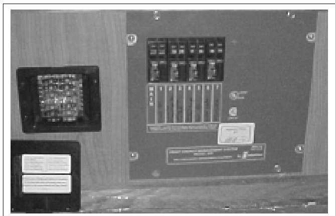
Fig. 10-16 120 VOLT CIRCUIT PANEL
